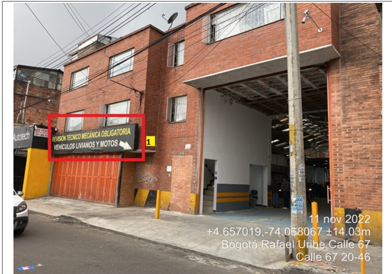
En la cual se evidencia un (1) elemento tipo aviso en fachada perteneciente al establecimiento comercial MEGASERVICE CAR propiedad de la sociedad MEGASERVICE SOFT LTDA , el cual al momento de la visita se encontraba instalado sin el registro ante la SDA.
